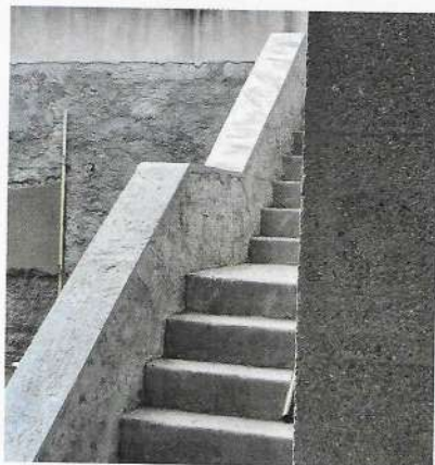
↑ Arase des rampants après décoffrage.
