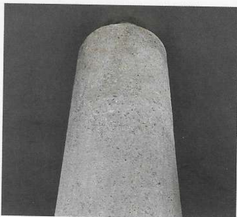
↑ Pilier après restauration.
