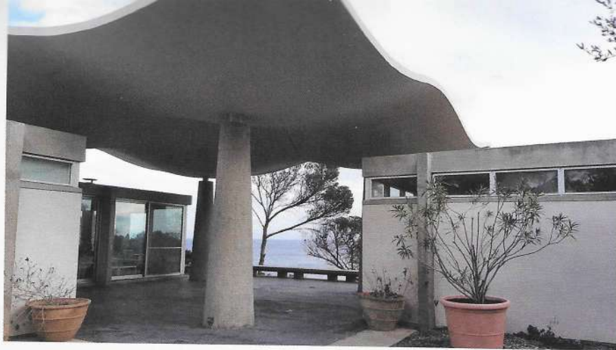
↑ Le patio surmonté d'un voile de béton ondulé.
